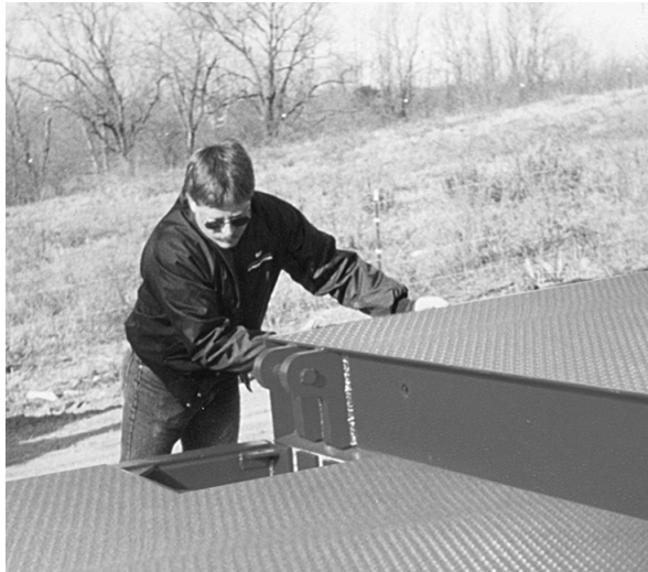
Figura 2-5. Instalación del Módulo B
