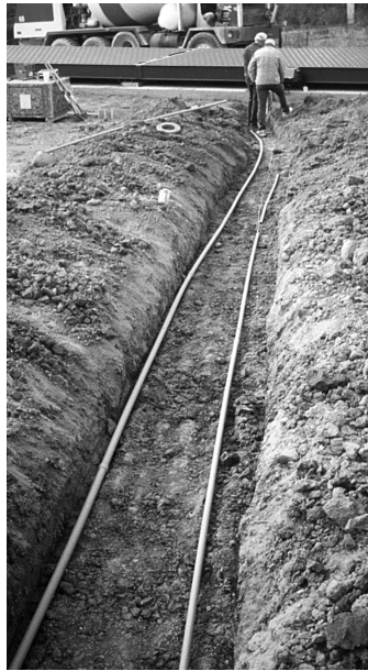
Figura 6-1. Trinchera de Corrida del Conduit
