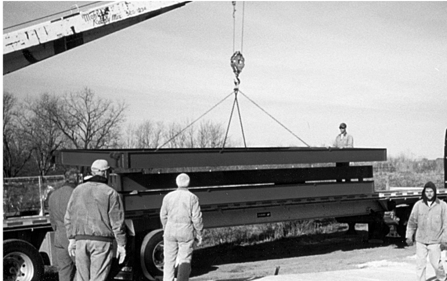
Figura 1-3. Levantando los Módulos de la Plataforma (Plataforma de Concreto)
