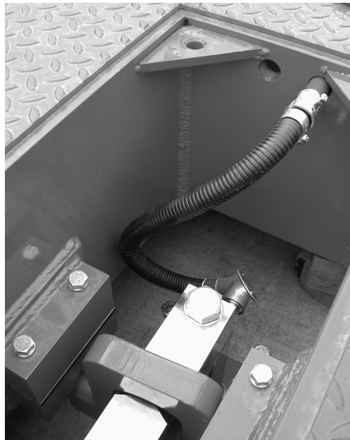
Figura 4-2. Conduit de la Cavidad de la Celda de Carga, Instalado
