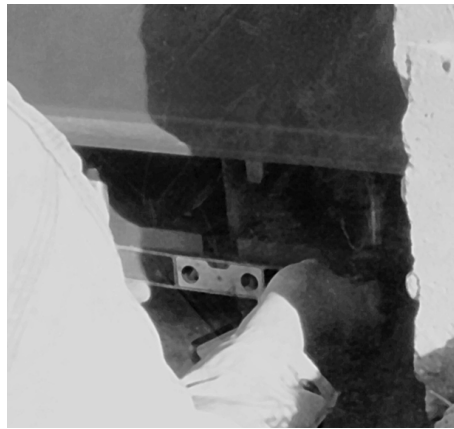
Figura 3-7. Verifique Eslabones por Torcedurass
