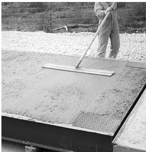
Figura 5-5. Bordeando el Concreto
