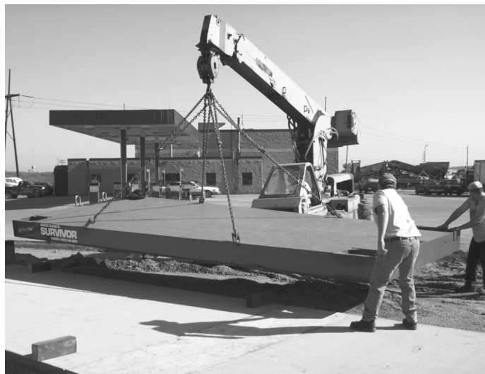
Figura 1-1. Levantando los Módulos de la Plataforma (Plataforma de Acero)
