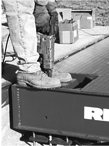
Figura 3-8. Taladre Perforaciones para los Tornillos de Anclaje
