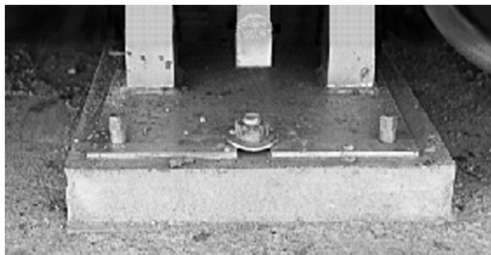
Figura 3-13. Lechareada de la Placa de Base Terminada
