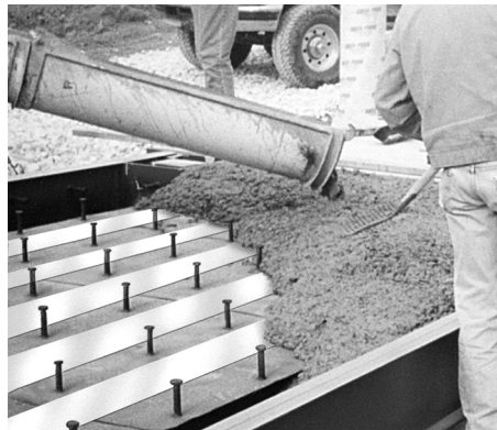
Figura 5-3. Vaciando el Concreto en el Módulo
