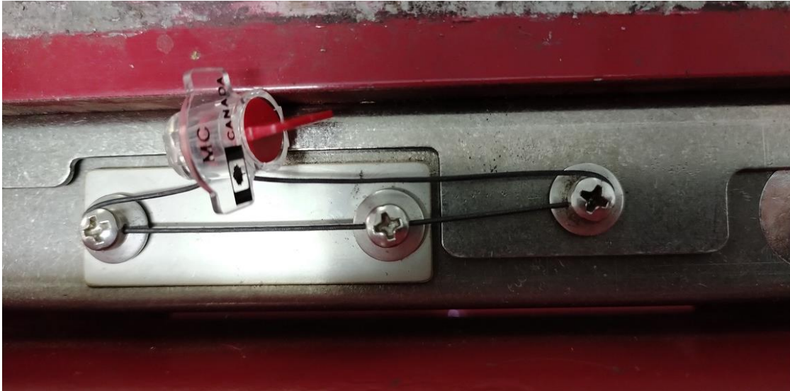
Typical sealing of the junction box/ Scellage typique de la boîte de jonction
