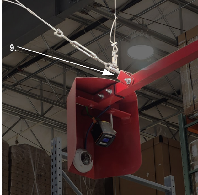
Figura 7. Conjunto de tensores a colgador
