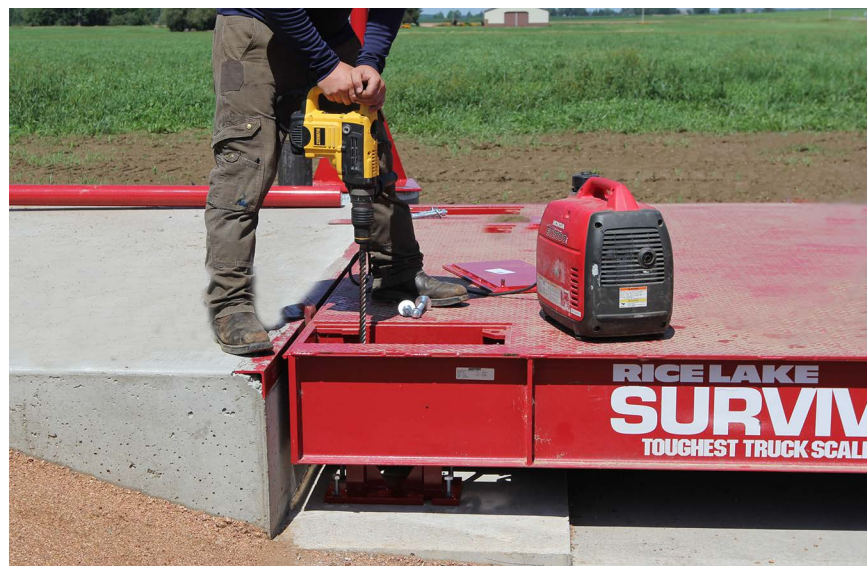
Figura 4-9. Taladre agujeros para pernos de anclaje
