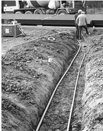
Figura 7-1. Canalización en zanja
