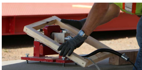
Figura 4-12. Encofrados temporales de madera alrededor de la placa base
