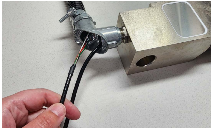
Figura 4-4. Instalación del racor de 90° a la celda de carga
