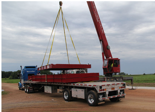
Figura 2-1. Elevación de los módulos de plataforma
