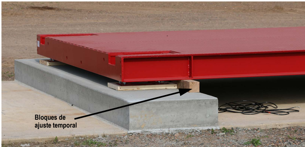
Figura 3-3. Módulo colocado sobre bloques de ajuste temporales
