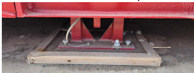
Figura 4-13. Placa base en bastidor con lechada
