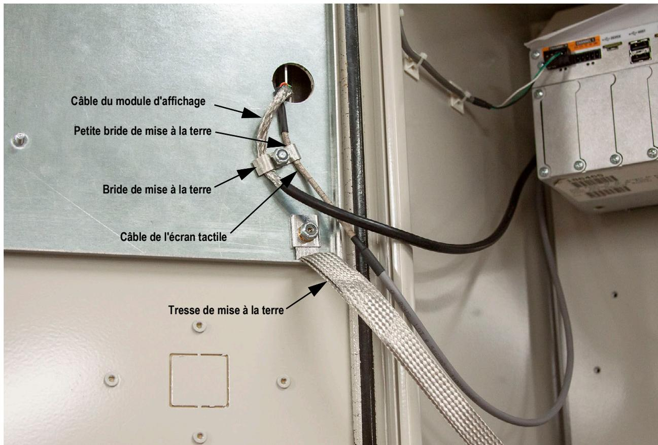
Figure 2-30. Mise à la terre du blindage pour installation à panneau
