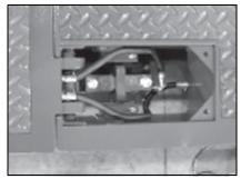
Figure 5-5. Conduit Connection Between Deck Modules
